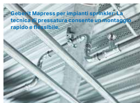
Indicatore ottico di pressatura e anello di tenuta per doppia sicurezza.
