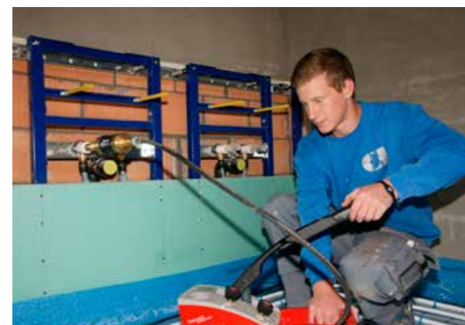
↑ PROVA PRESSIONE IGIENICAMENTE SICURA Una pompa di prova viene utilizzata per pressurizzare una sezione di tubo già riempita d'acqua. Il filtro igienico previene la contaminazione delle nuove tubazioni durante la prova pressione.
